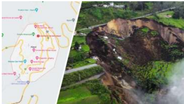
Ilustración 1: Deslizamiento Alausí Fuente: PRIMICIAS
